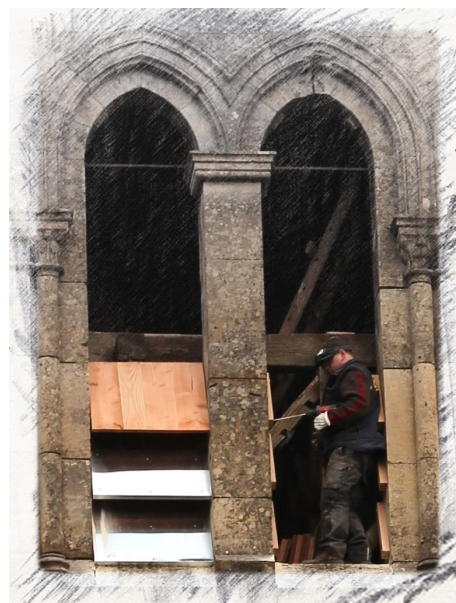
Remplacement des abat-son
