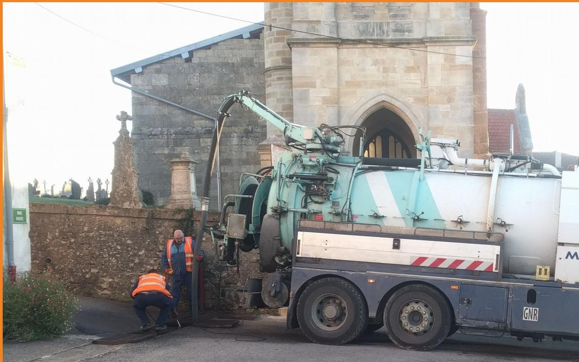
Le nettoyage des avaloirs du réseau pluvial qui se remplissent de sable ou de gravier au fil du temps a été réalisé par l'entreprise Malézieux de Comblés en Barrois
